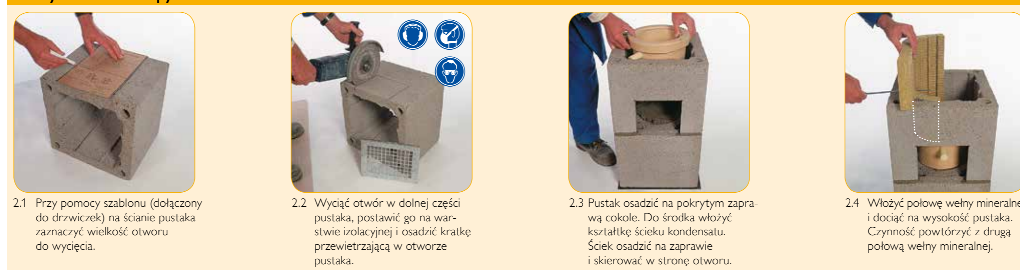
Obie części płyty czołowej z wełny mineralnej dociąć do wielkości wyciętego otworu. Nasunąć uchwyty metalowe, wsunąć razem w otwór w pustaku.
