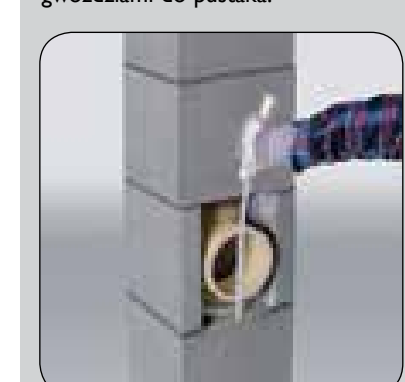
Obie części płyty czołowej dociąć do wielkości otworu w pustaku.
